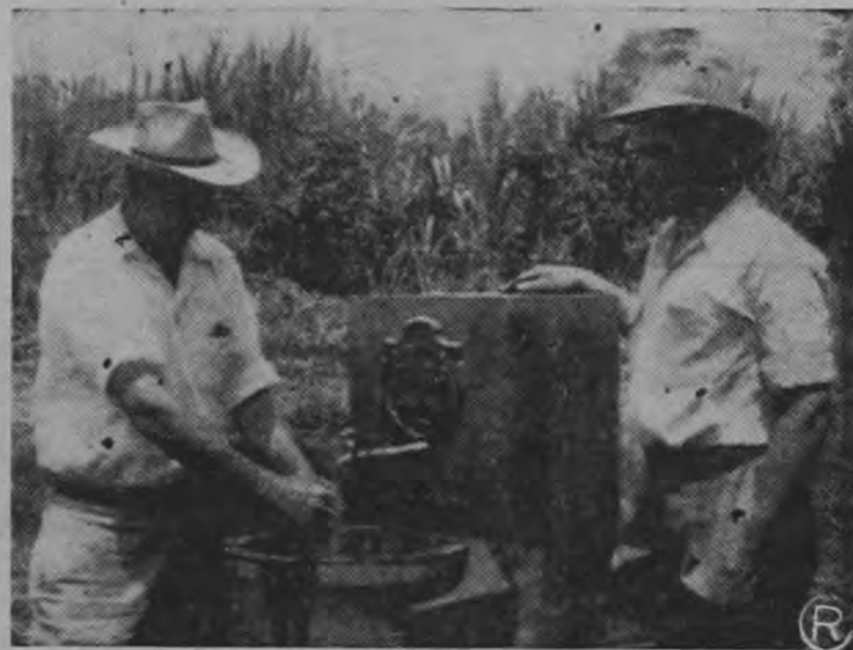
Esta cañería es la de Puente de Piedra. Debido a diámetro insuficiente para el caudal existente, se está cambiando toda la tubería de conducción, mejorando así el servicio.
