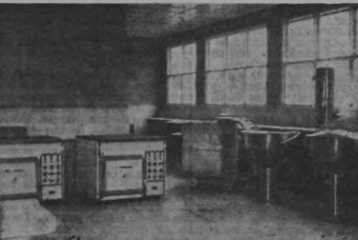
COCINA DEL HOSPITAL
